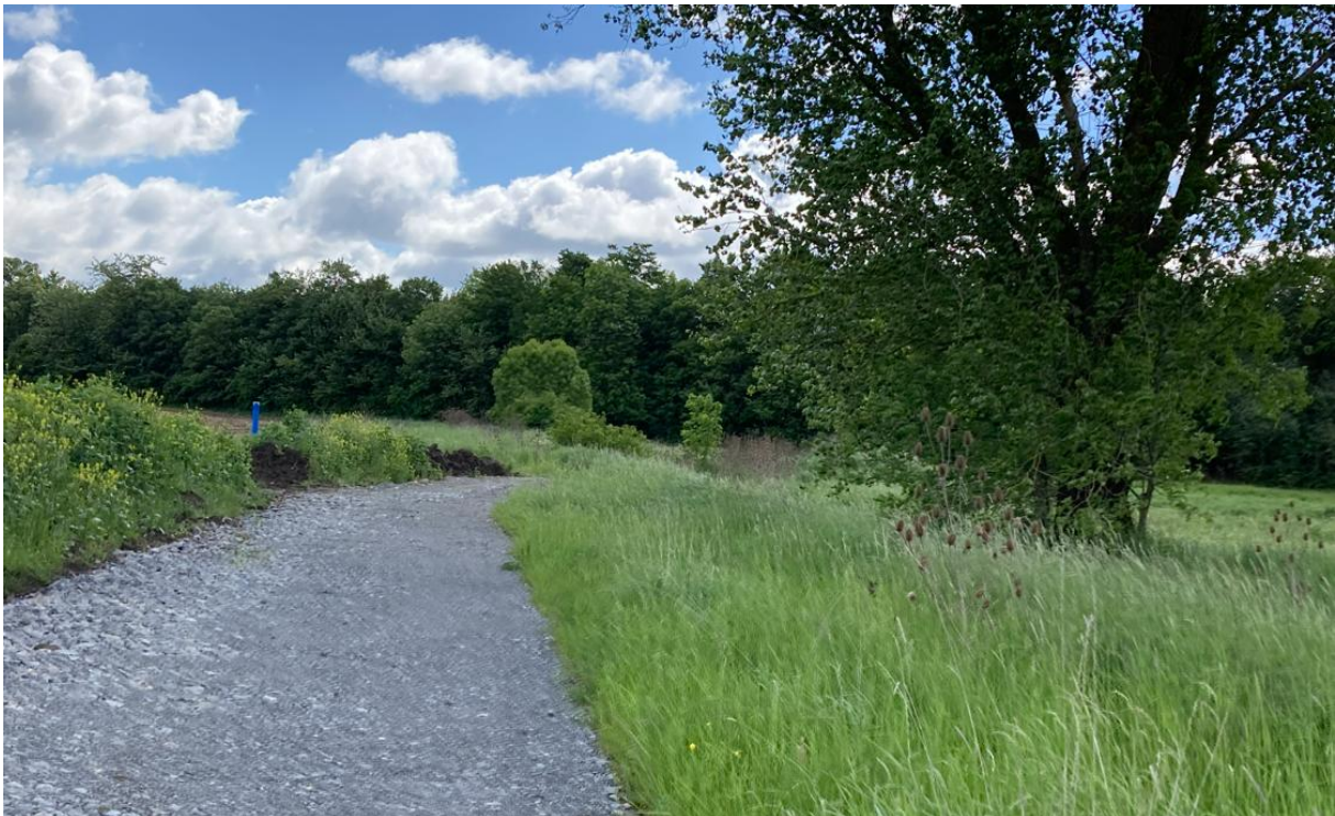
Abb.12 Baustraße bauseits vorhanden- unterhalten, bei Bedarf umverlegen, unterhalten und am Ende der Maßnahme zurückbauen, links vorhandene Bodenmiete des AG
