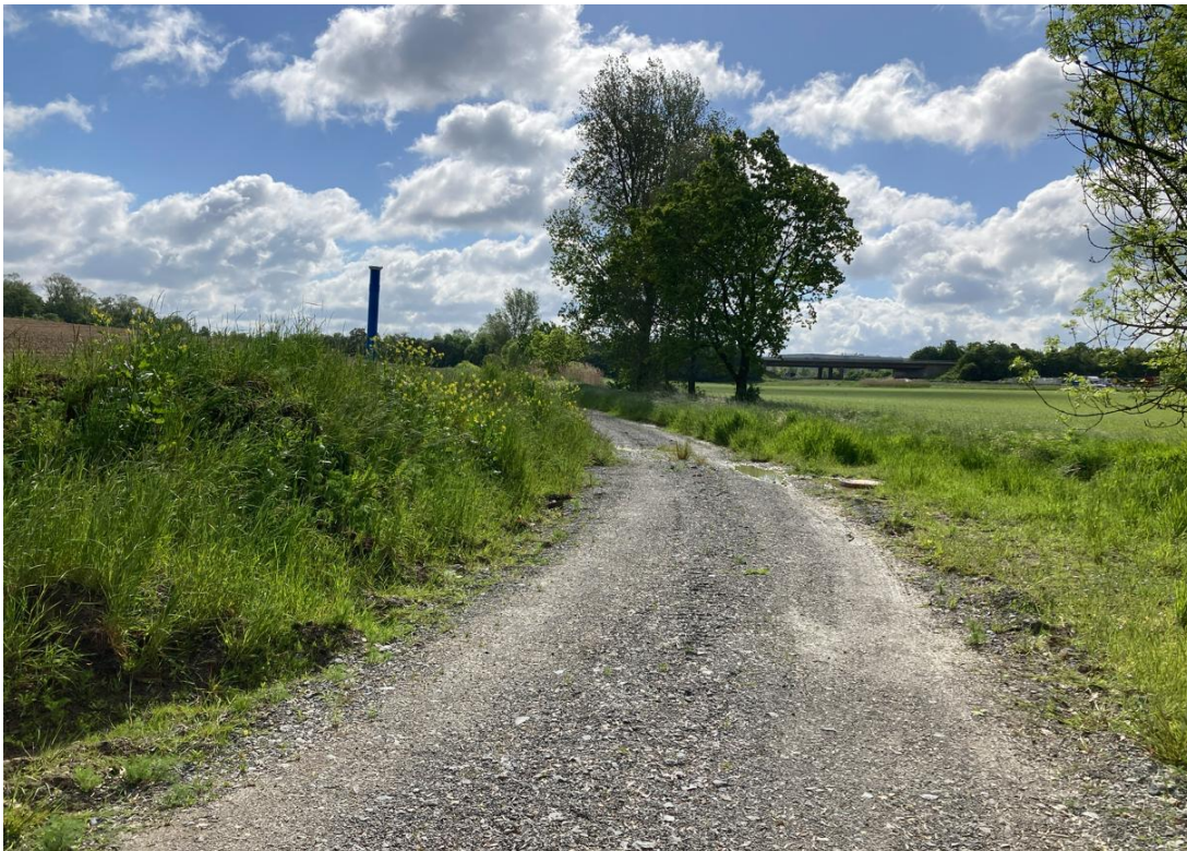
Abb.10 Baustraße bauseits vorhanden- unterhalten, bei Bedarf umverlegen, unterhalten und am Ende der Maßnahme zurückbauen, links vorhandene Bodenmiete des AG und Grundwassermessstelle, rechts Schacht
